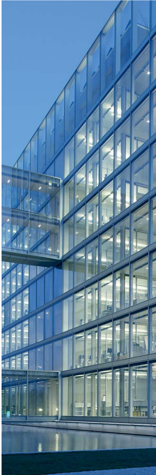
Projet Gelsenwasser AG, Gelsenkirchen Allemagne
